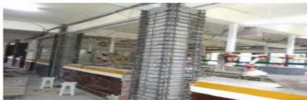
施工中(「鋼筋綁紮(封模前)」階段)
