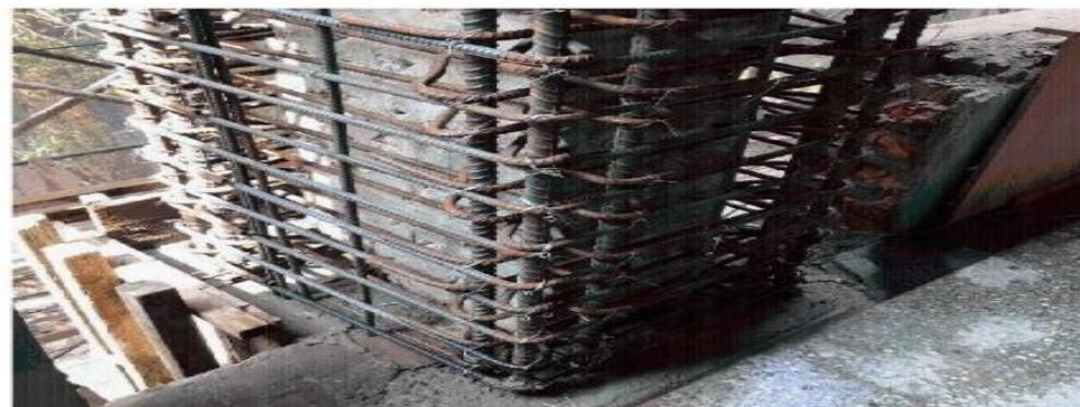
施工中(「鋼筋綁紮(封模前)」階段)
