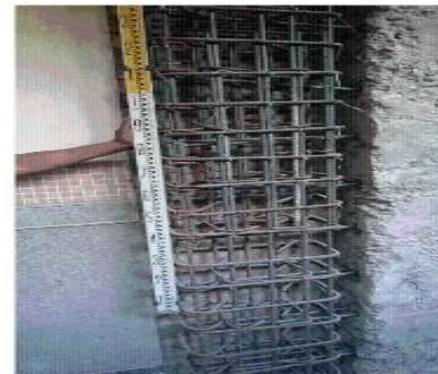
施工中(「鋼筋綁紮(封模前)」階段)
